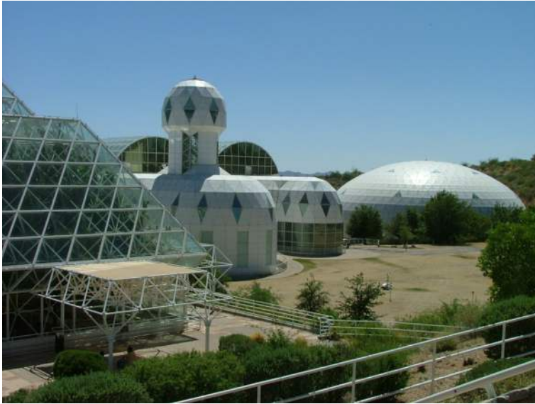
FIGURE 4. Vue du complexe Biosphere 2, avec les quartiers d'habitations et le «poumon» de la structure (CC BY 2.0: DrStarbuck).
